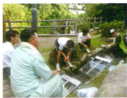
▲同発電機設置の様子
